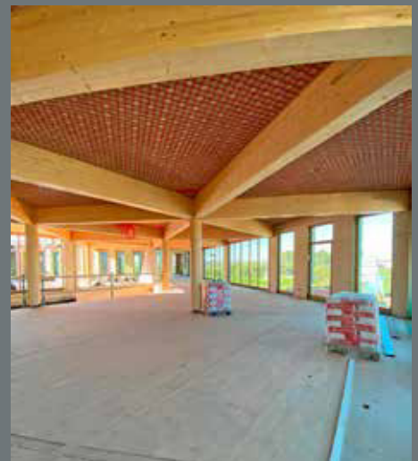
Die Deckenkonstruktion war eine besondere Herausforderung: Alle Deckenmodule wurden einzeln mit einer CAD-Software geplant, um den Holzbau mit den nötigen Infos zu Aussparungen in den Balken zu versorgen Foto: Argillatherm
