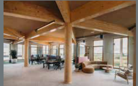
Die „Natur-Klimadecken“ lösen die Taupunktproblematik bei der Flächenkühlung, ohne zentrale Lüftungsanlage und Taupunktüberwachung Foto: Evabloem
