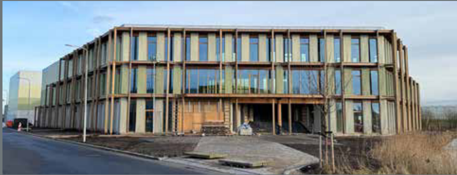
Im neuen Hauptsitz des Outdoor-Spezialisten Bever in Südholand wurde der Verwaltungsbereich auf knapp 1300 m² Fläche mit „Natur-Klimadecken“ von Argillatherm ausgestattet Foto: Argillatherm
