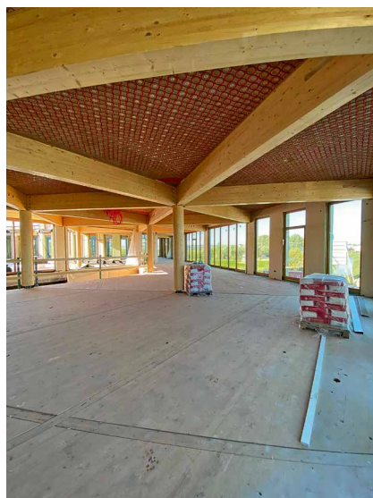
Die Deckenarchitektur war eine besondere Herausforderung. Daher wurden alle Segmente einzeln mit CAD geplant, um den Holzbau mit den nötigen Infos zu Aussparungen in den Balken zu versorgen. [© Argillatherm]
