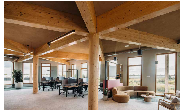
Die Natur-Klimadecken lösen die Taupunktproblematik – eine der größten Herausforderungen bei der Flächenkühlung – ohne zentrale Lüftungsanlage und Taupunktüberwachung [© Evabloem]
