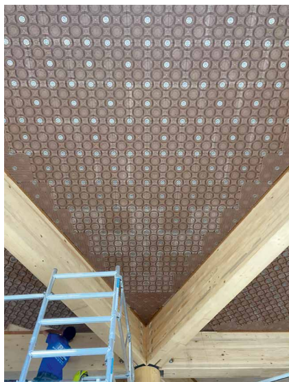
Die Humid-Module wurden an der Decke verschraubt und die nötigen Aussparungen sowie weitere Befestigungspunkte bei der Montage berücksichtigt [© Argillatherm]
