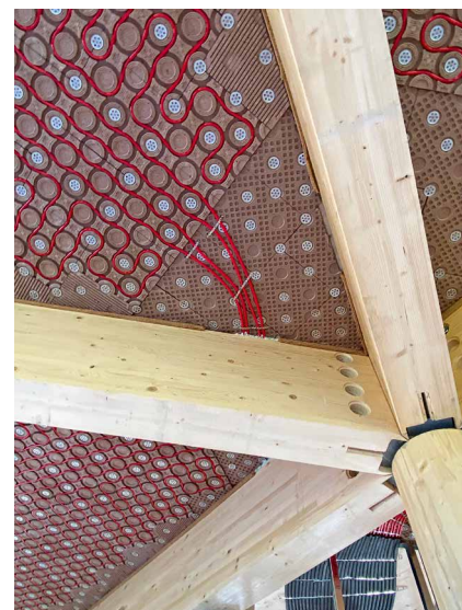
Alle Rohrleitungen für die Heiz-Kühl-Funktion konnten kupplungsfrei verlegt werden [© Argillatherm]
