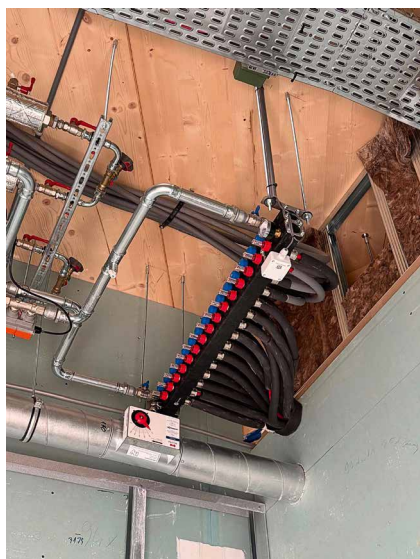
Die Heiz-/Kühlflächen werden an den Heizkreisverteiler angeschlossen. Das Besondere: Die Verteiler sind doppelwandig und vor Tauwasser geschützt. [© ArgillaTherm]
