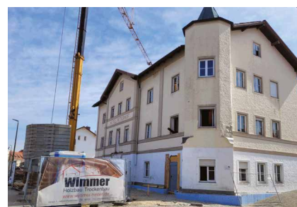
Das ehemalige Hotel »Peterhof« in Neumarkt-St. Veit vor Beginn der seriellen Sanierung – ein traditionsreiches Gebäude mit bewegter Geschichte [© Wimmer Holzbau Trockenbau GmbH]
