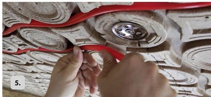
ßen Tagen sogar eine Entfeuchtungsanlage. Eine solche Ausstattung ist in Anschaffung und Betrieb sehr kostenintensiv. Bei den Humid-Modulen von ArgillaTherm übernehmen Tonminerale die Aufgabe, das durch die Kühlung anfallende Kondenswasser aufzunehmen. Pro Quadratmeter können sie bis zu 1,7 Liter Wasser absorbieren, ohne
