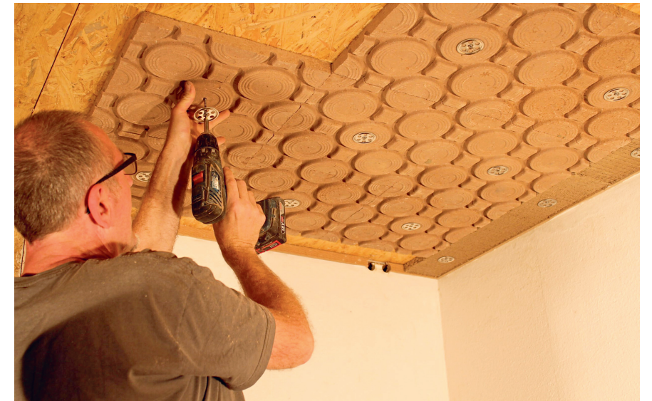
Die Natur-Klimasysteme lassen sich an Decke, Wand und sogar Boden montieren und eignen sich für den Neubau wie für Bestandsbauten.
