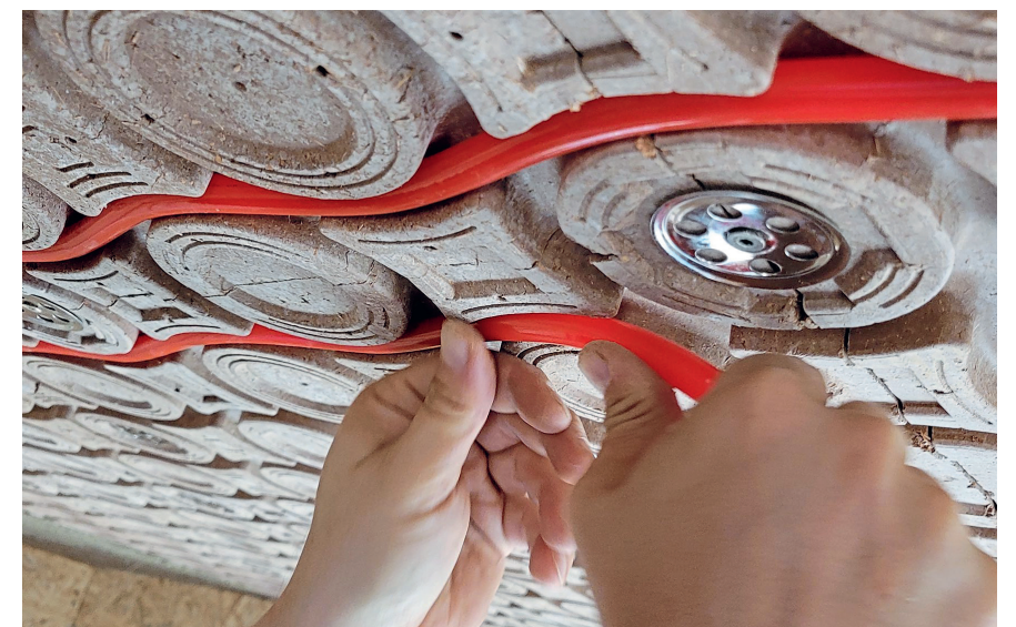
Einziehen der Rohrleitungen, durch die später wahlweise kaltes oder warmes Wasser fließt.
