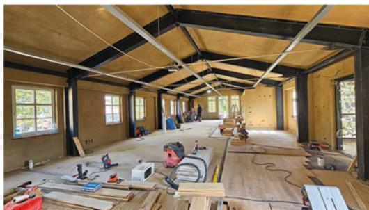
Die Saaldecke stellte bei der Planung der aktiven Heiz- bzw. Kühlflächen eine besondere Herausforderung dar, da die sichtbare Stahlrahmenkonstruktion die Deckenfläche unterbricht [© Gemeinde Schorfheide]
