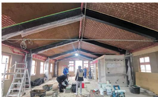
Die einzelnen Deckenfelder wurden mit den notwendigen Heizkreisen jeweils einzeln am Heizkreisverteiler angebunden, was eine felderspezifische Regelung ermöglicht [© Spreepjan Projekt UG]
