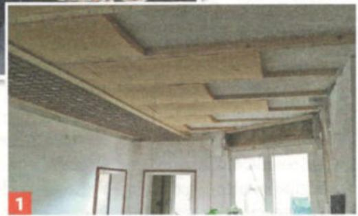
Die Lehmdeckenheizung von *ArgillaTherm* besteht aus 5 kg schweren Lehmmodulen mit sehr hohem Tonanteil, die auf ihrer Rückseite Rillen aufweisen. Darin können Rohre für eine Warmwasserheizung oder in anderer Ausführung für elektrische Heizkabel verlegt werden. Wichtig: Stabile Dachlatten als Unterkonstruktion! **1** Hier wurde neben den Latten auch eine Holzfaserdämmung angebracht, um den Wärmeschutz des Flachdaches zu verbessern. **2** Man beginnt
