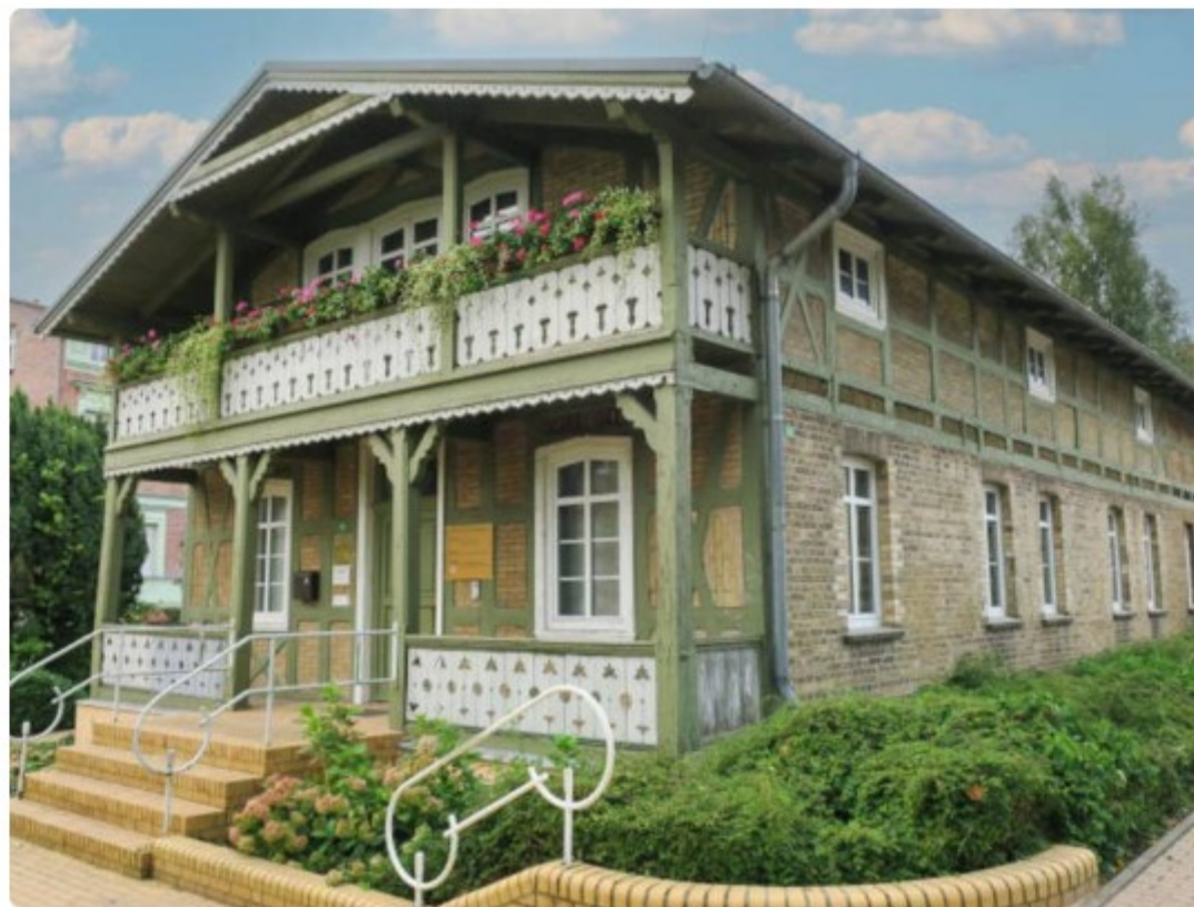
Das ortsprägende Fachwerkhaus wurde saniert und ist nun als Dorfgemeinschaftshaus Treffpunkt für den ganzen Ort. (Bild: Gemeinde Schorfheide)
