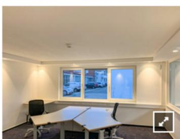
Die Natur-Klimadecke heizt die Büros mit Strahlungswärme von oben. Das Lehm-/Ton-Gemisch absorbiert Gerüche und Schadstoffe aus der Luft. © ArgillaTherm
