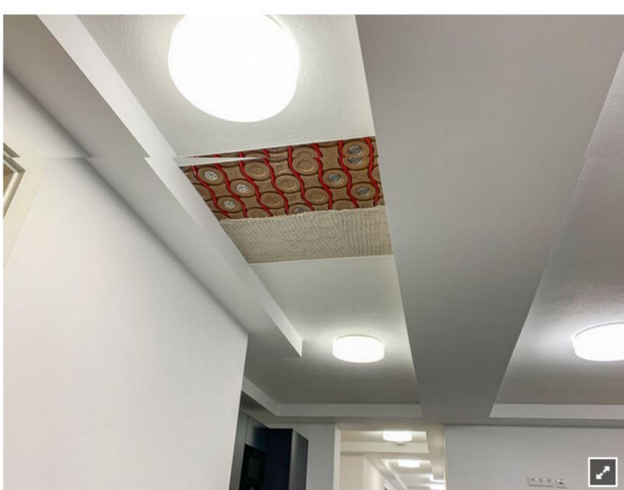
Auf der ganzen Fläche wurden Natur-Klimadecken aus Hochleistungs-Lehmmodulen installiert. Eine Schauffläche zeigt den Systemaufbau. © ArgillaTherm
