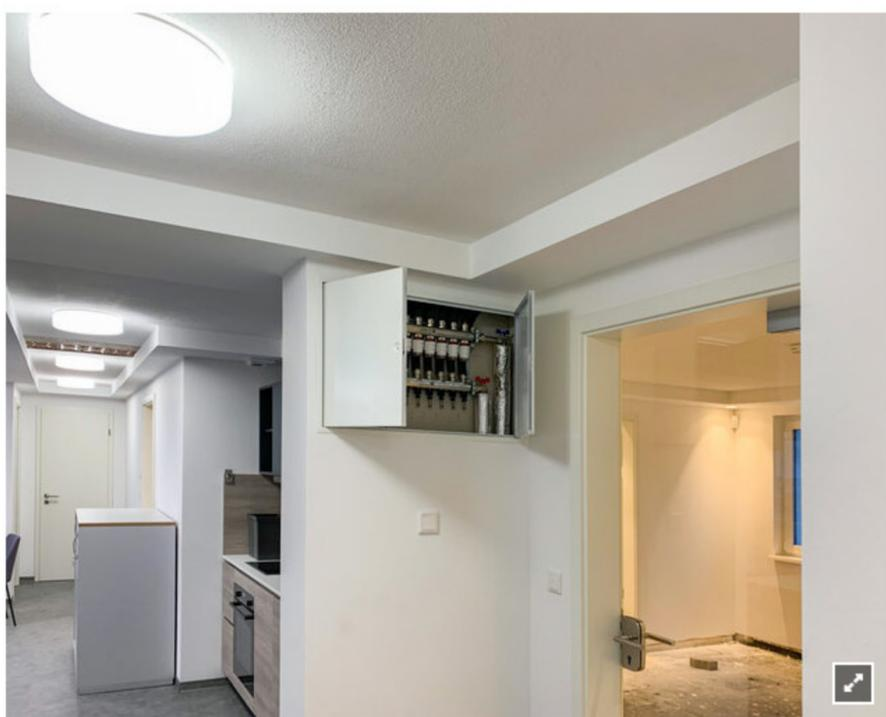
Der Heizkreisverteiler befindet sich im Flur. Von hier aus werden die einzelnen Heiz-/Kühlflächen über ein Ringleitungssystem versorgt. © ArgillaTherm
