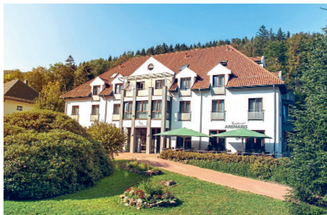
Das Aktivhotel Inselsberg im laufenden Betrieb mit einem Deckenheiz- und -kühlssystem ausgerüstet.
