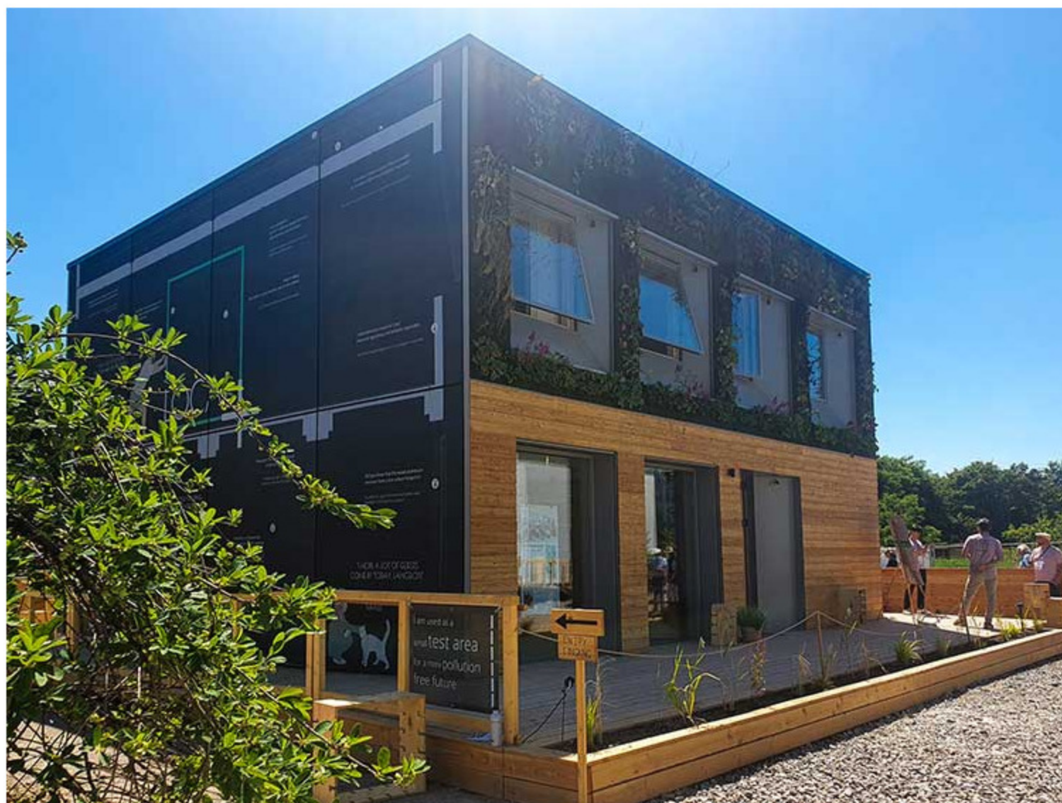
Urbanes Bauen der Zukunft: Ein Team der FH Aachen entwarf ein Gebäude in Holzständerbauweise für eine zwölfköpfige Wohngemeinschaft. Eine kleine Version ist auf dem Solar Campus in Wuppertal zu sehen. (Foto: ArgillaTherm)
