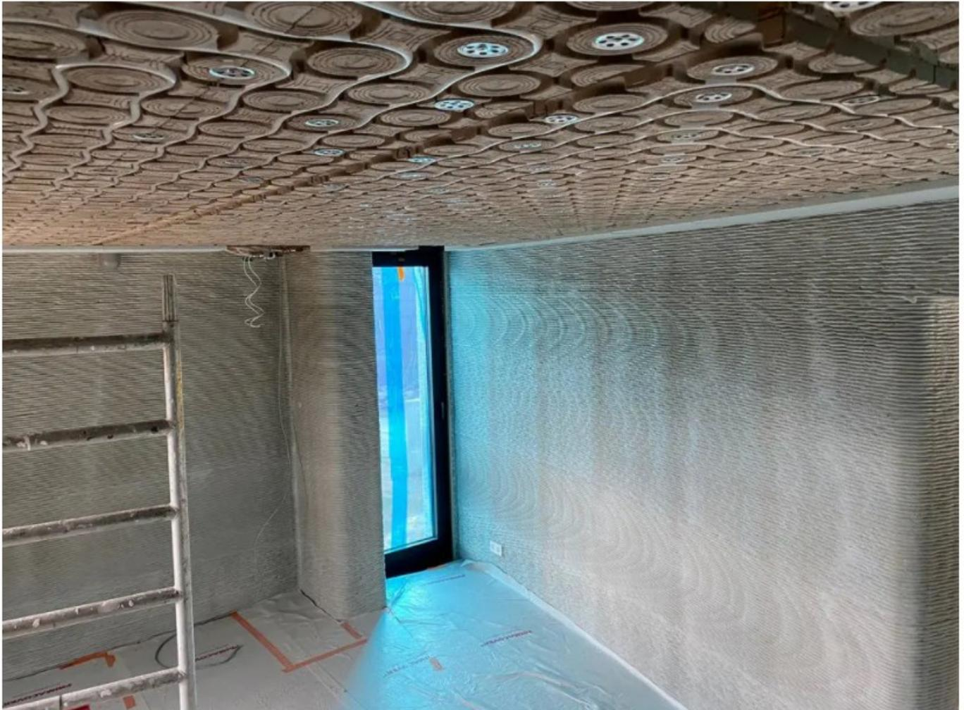
*Das Betonhaus wurde mit einer Natur-Klimadecke aus Hochleistungs-Lehmmodulen ausgestattet. Durch die Schlauchleitungen strömt je nach Bedarf warmes oder kaltes Wasser.*
