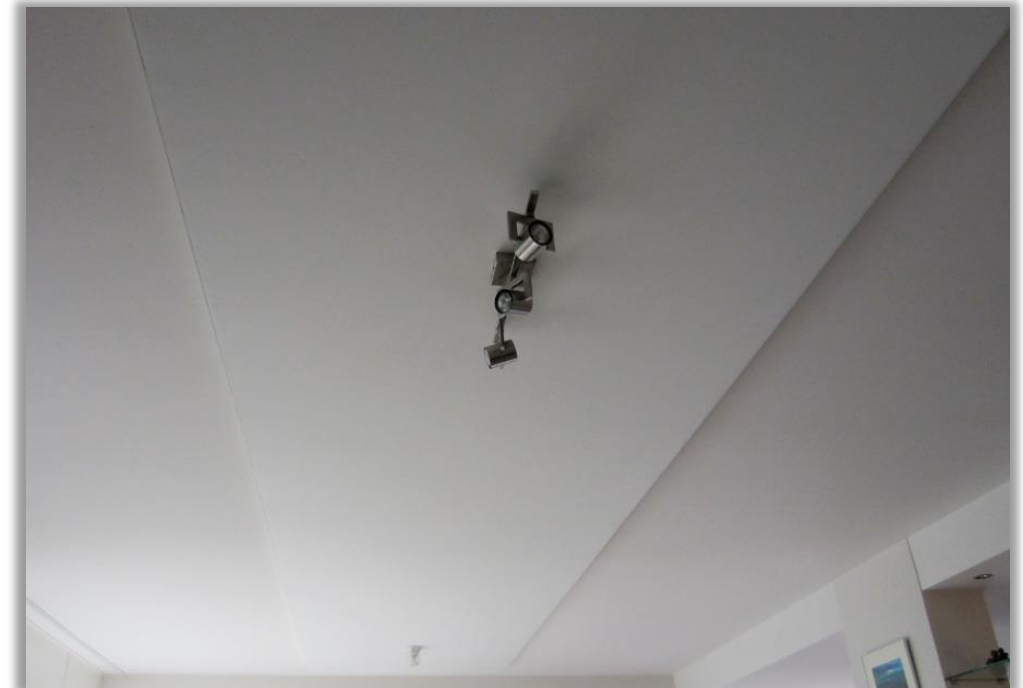
Deckensegel nach Oberflächenbeschichtung
