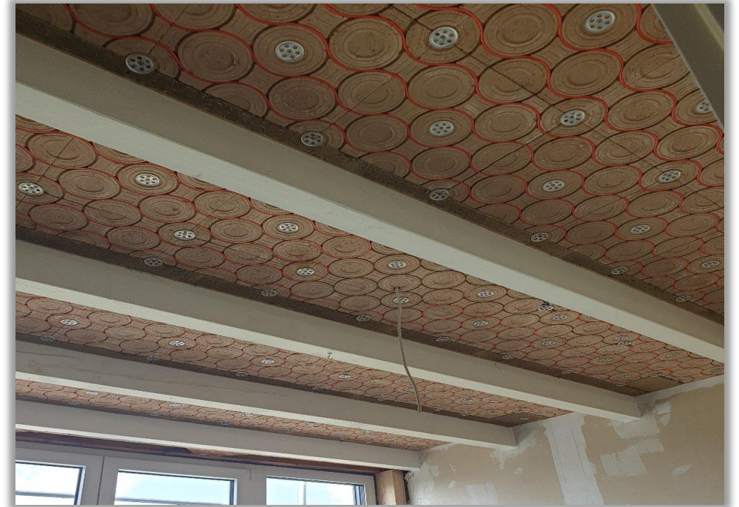
Sichtbalkendecke mit Belegung der Balkenzwischenräume
