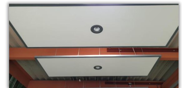
fertige Deckensegel, max. 3,5m 2
