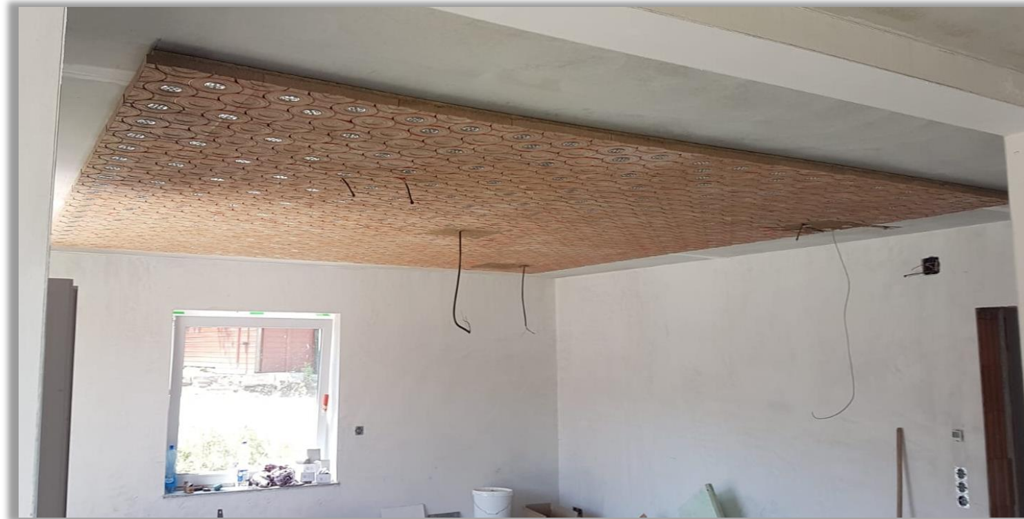
Deckensegel vor Oberflächenbeschichtung
