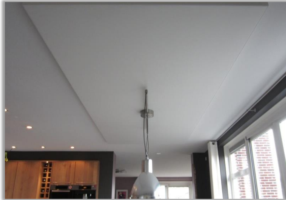
Deckensegel nach Oberflächenbeschichtung
