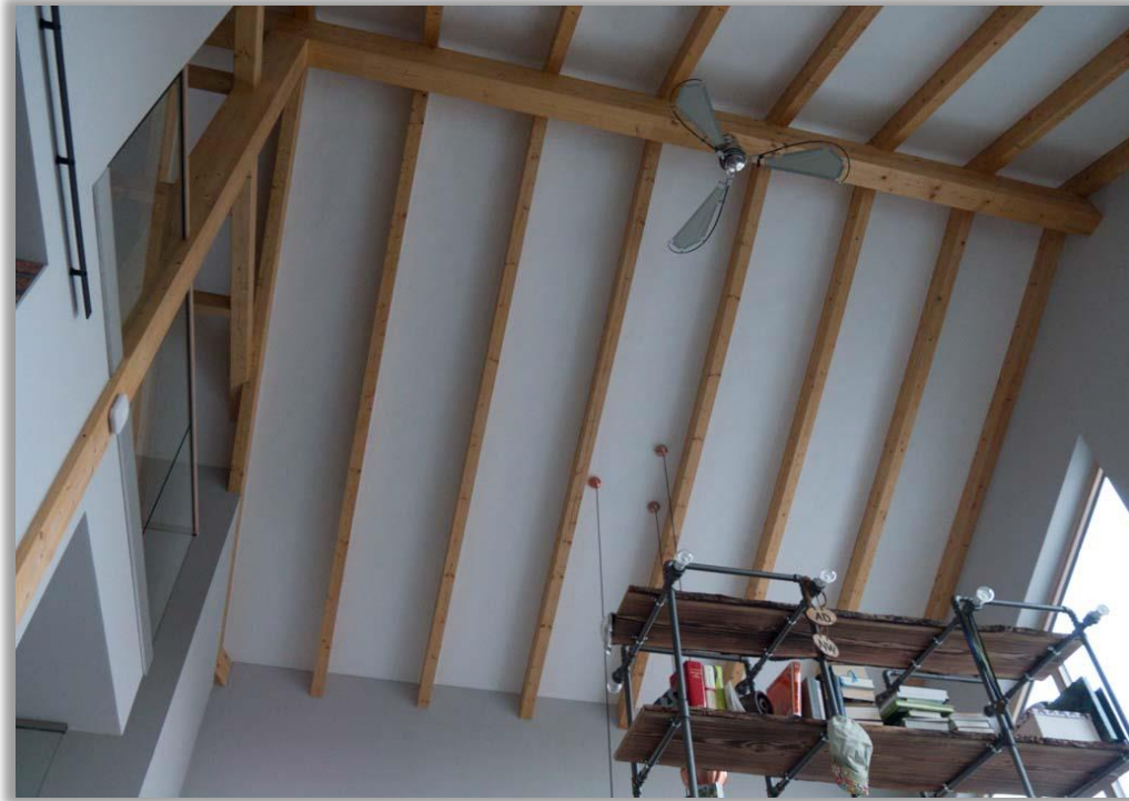
Sichtbalkendecke mit Belegung der Balkenzwischenräume
