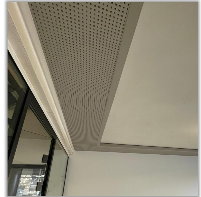
Variante III raumumlaufendes Fries z.B. Knauf Cleaneo Akustik SK 8/18 Q farblich individuell gestaltbar
