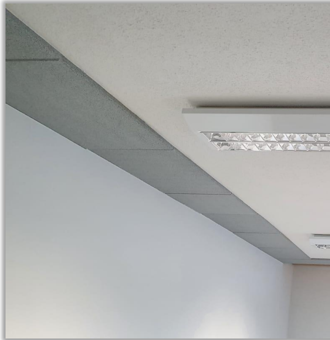
Variante II Ringabsorber aus Blähglas Befestigung auf der UK 18mm Überstand
