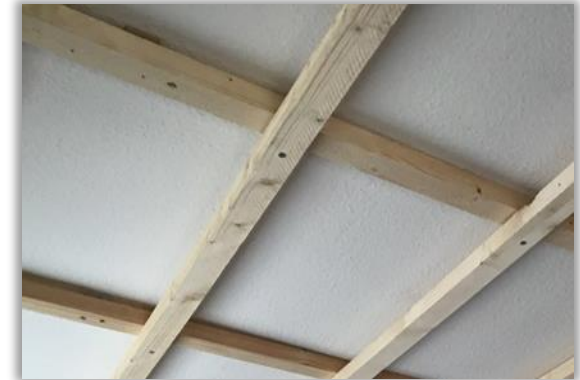
kreuzlagige Lattung (direkte Befestigung)
