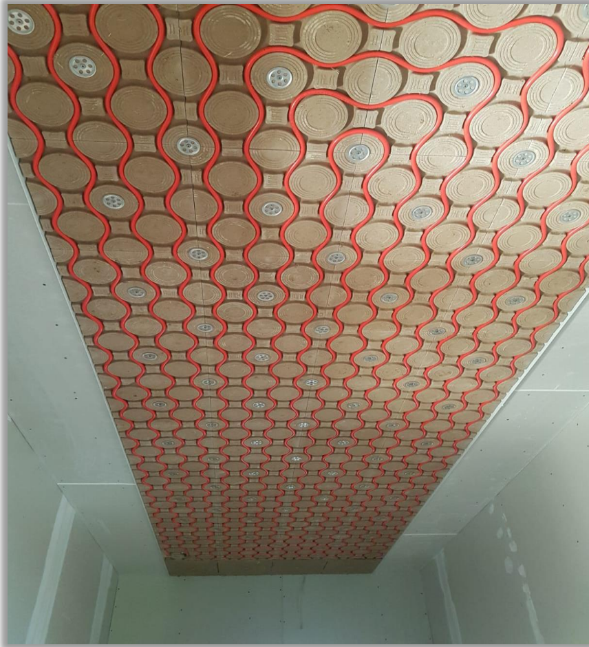
Deckensegel im Rohbau
