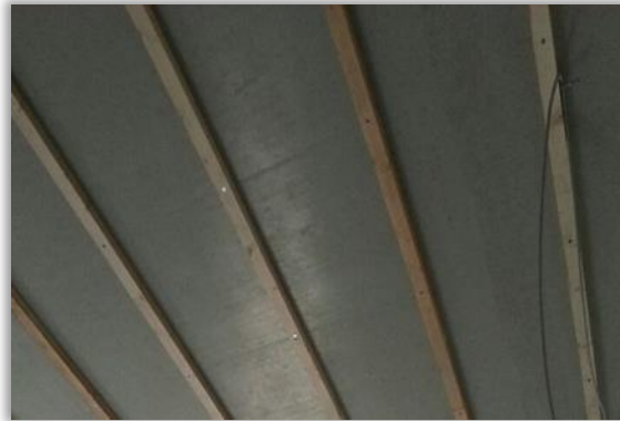
einlagige Holzlattung (direkte Befestigung)
