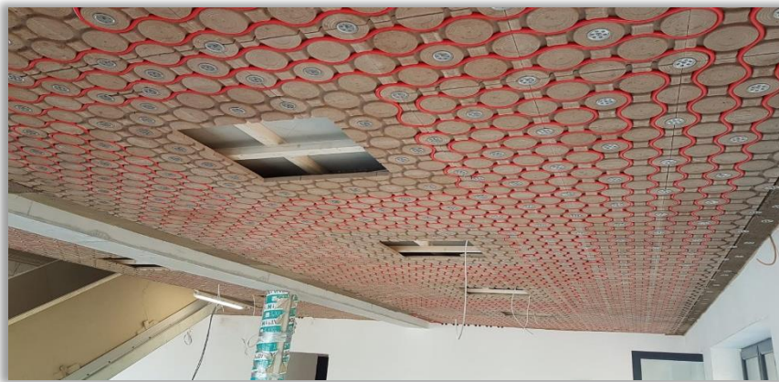
Integrierung von Lampen, REVI-Klappen, etc.
