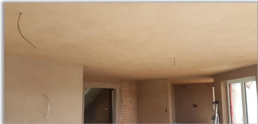
Gewebelage mit HUMID-Universalputz vor Aufbringung der feinkörnigen Lehmfarbe.
