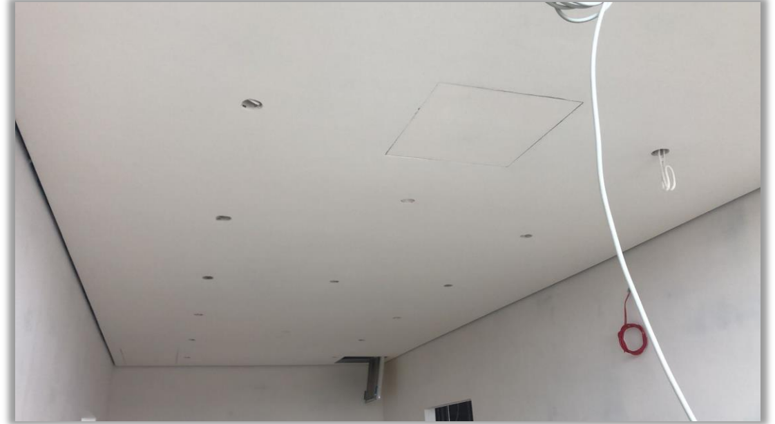
Freihängend mit umlaufender Schattenfuge
