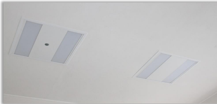
Einbauleuchten, Revi-Klappen
