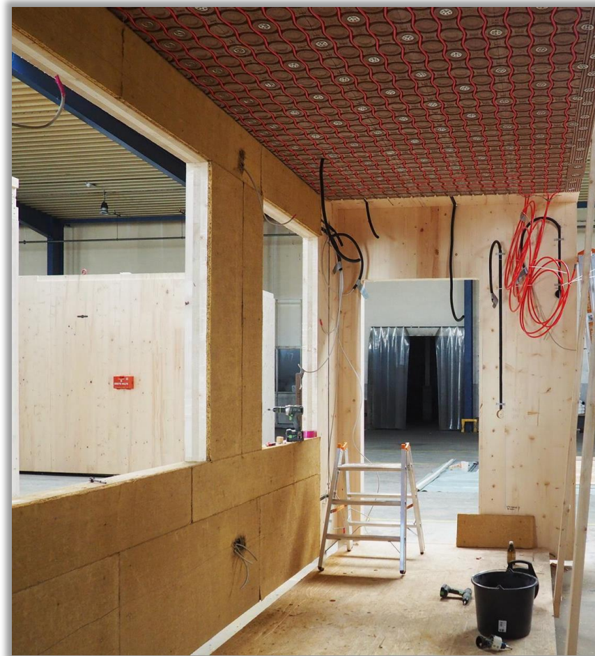
Werkseitig komplett vorgefertigte Cubes, Farbanstrich auf der Baustelle
