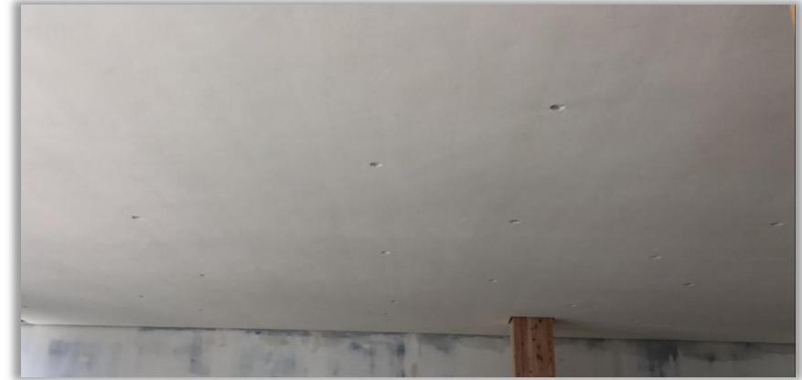
Gewebelage mit Kalkputz vor Aufbringung der Kalkfarbe.
