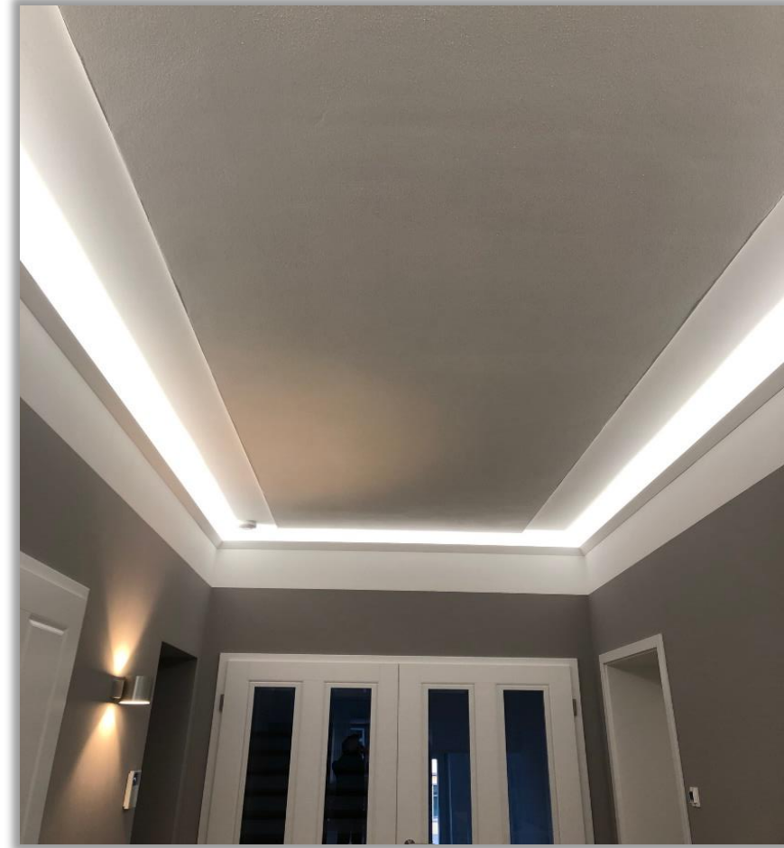
Deckensegel nach Fertigstellung
