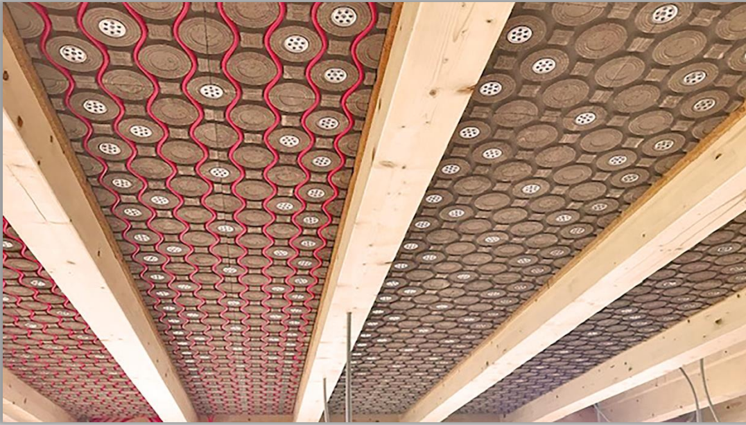
Sichtbalkendecke mit Belegung der Balkenzwischenräume
