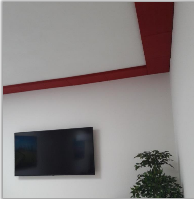
Variante I Ringabsorber aus Blähglas Nachträgliche Montage 48mm Überstand
