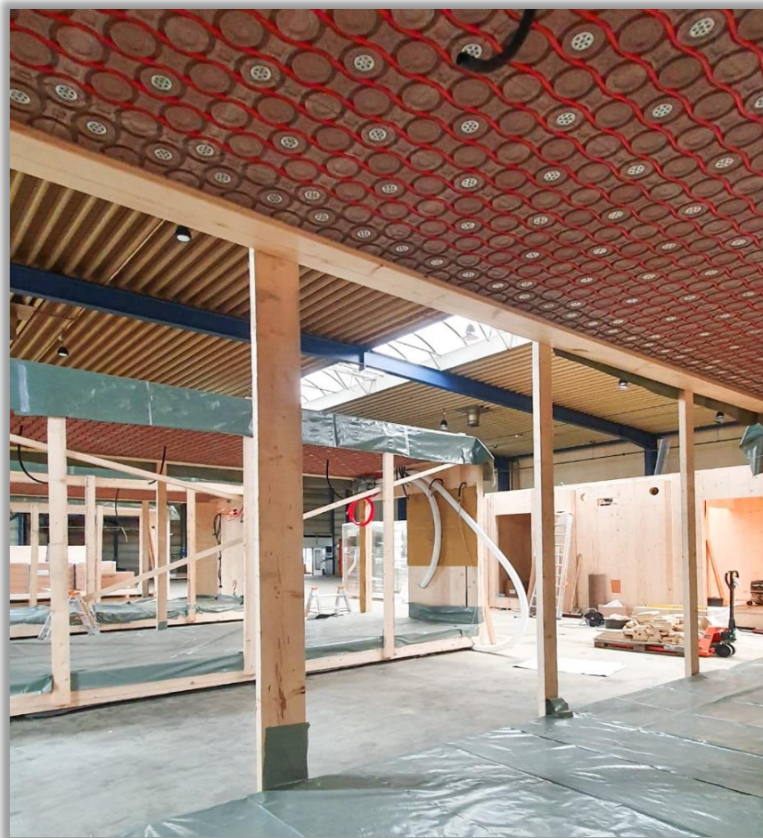
Werkseitig komplett vorgefertigte Cubes, Farbanstrich auf der Baustelle
