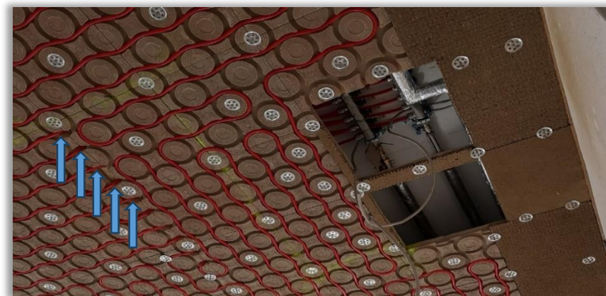
Montage an Abhangkonstruktion
