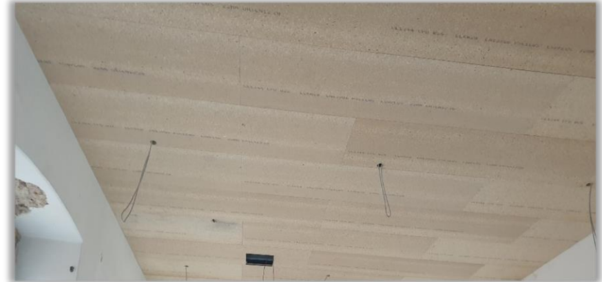
Montageebene an Abhängung befestigt
