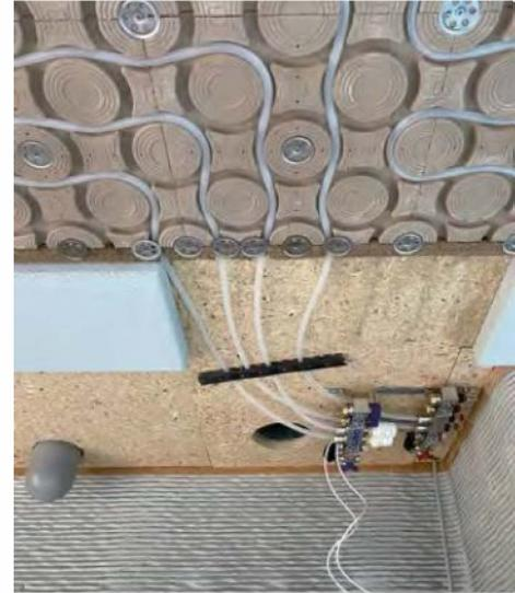
Anbindung der Natur-Klimadecke an den Heizkreisverteiler.
