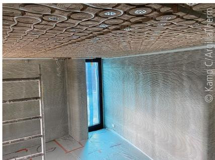
Das mit einem 3-D-Drucker gebaute Betonhaus wurde mit einer Naturklimadecke aus Hochleistungslehmmodulen ausgestattet
