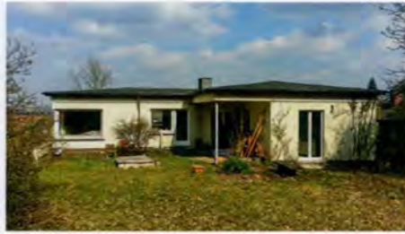
Sanierungsbedürftig: Anstelle der alten Ölheizung erhielt der knapp 60 Jahre alte Flachdachbungalow eine wohngesunde Lehmklimatecke [© ArgillaTherm]
