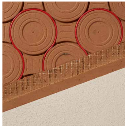
Elektrisches Direktheiz-System, Decke Lehmputz THERMO mit Bewehrungsgewebe Anstrich mit CLAYTEC Lehmrollputz
