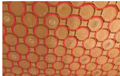
Hochleistungs-Lehmmodule verlegt, danach Einbau der Rohrleitungen
