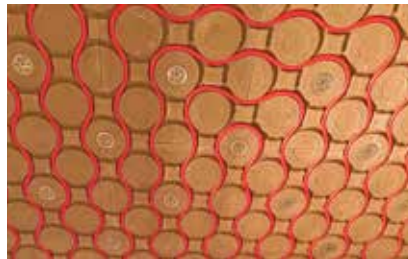
Hochleistungs-Lehmmodule verlegt, danach Einbau der Rohrleitungen
