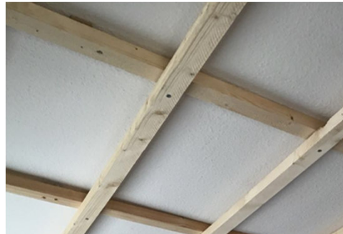
kreuzlagige Lattung (direkte Befestigung) Niveaueausgleich über Stell-schrauben möglich
